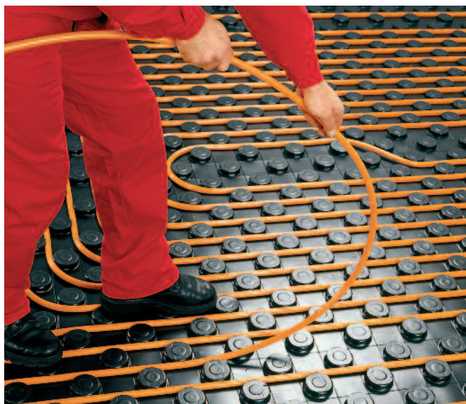
Do systémové desky se mohou vkládat trubky s rozměry 15, 16, 17 a 18 mm ve vzdálenostech 75, 150, 225 a 300 mm buď ve formě spirály, nebo meandrovitě.
