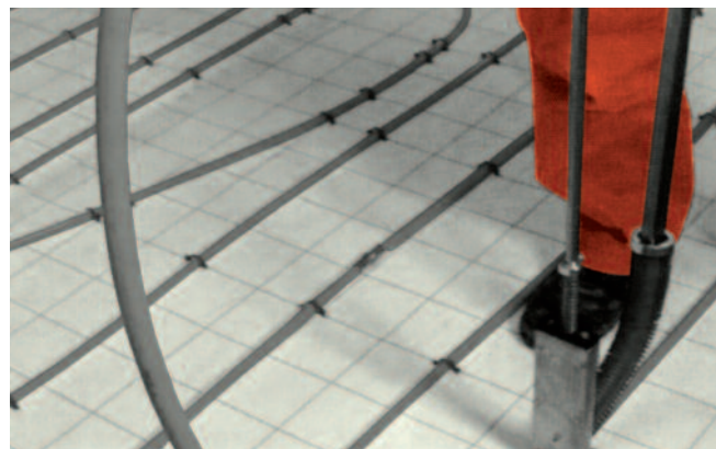
Trubka se upevňuje na systemový pás pomocí montážního přístroje a kotvicích spon.
