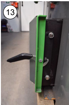
Zdj.13. Drzwi popielnika (sposób zamknięcia- niedomknięte)
