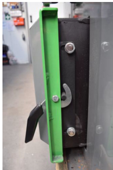
Zdj.13. Drzwi popielnika (sposób zamknięcia- prawidłowo zamknięte)
